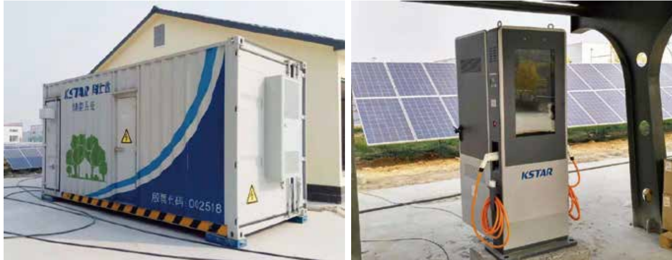
► 50 kW/200 kWh BESS für EV-Ladestation in Hebei
